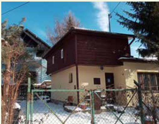
Jeden z domów dawnego osiedla TOR
